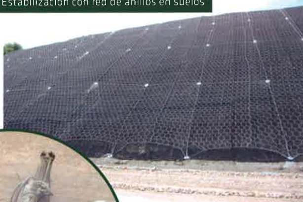
Estabilización con red de anillos en suelos
