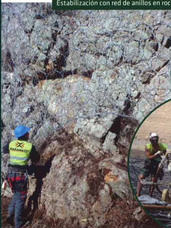
Estabilización con red de anillos en roca
