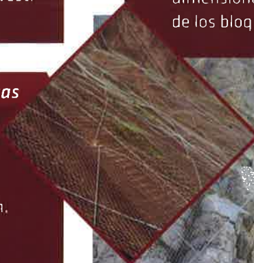
Detalle malla triple torsión reforzada
