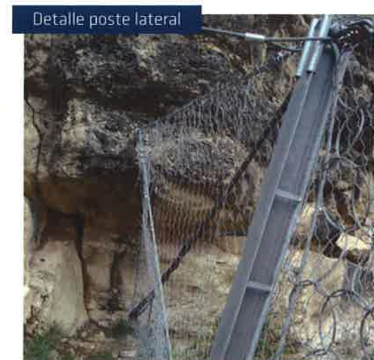
Detalles anclajes cable
